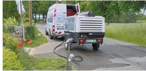
**So sieht es aus, wenn die Spülung im Gange ist: Links das erste Spülwasser, rechts das Ergebnis hinterher. Der Kompressor in der Mitte „schießt“ das Luft-Wasser-Gemisch durch die Rohre.** Fotos: SPREE-PR/Archiv
