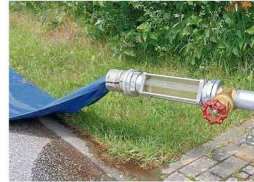
Durch die Rohre wird dann mit hohem Druck ein Luft-Wasser-Gemisch geleitet, es kommt zu Verwirbelungen, welche alle Ablagerungen ablöst und die gelösten Stoffe werden aus dem Rohrnetz gespült. **Alles ohne den Einsatz von Chemikalien oder sonstigen Zusatzstoffen.** Aus trübem Trinkwasser wird am Ende klares Trinkwasser. **„Gespült wird ausschließlich nachts von ca. 22.00 Uhr - 5.00 Uhr,**
